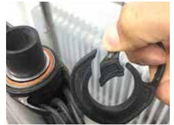
legen Sie den Spacer nach innen, um die Kabel durch den ersten Schlitz zu führen; anschließend führen Sie die Kabel durch den zweiten Schlitz.
